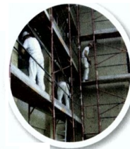
Fassadendämmung, mit Hanfplatten komplett (Raum-)klimafreundlich
