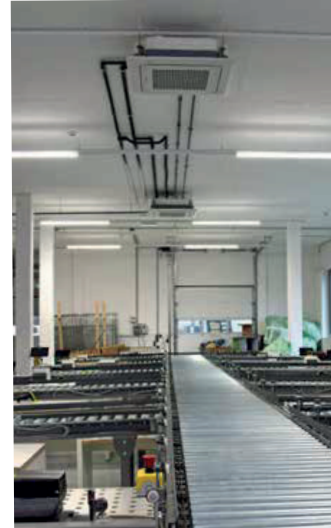
Blick in den neuen Kommissionierbereich.
