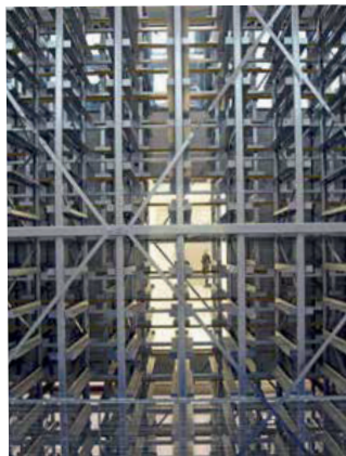
Im Hochregallager darf die Temperatur maximal 19° C betragen – ein weiterer Grund für die Klimatisierung mit Samsung DVM S Anlagen.
