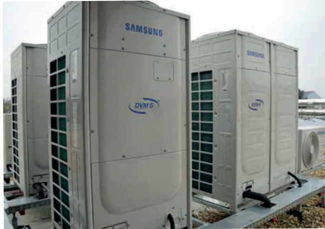
Sechs Außeneinheiten des Samsung-DVM S-Systems wurden am Dach platziert – je nach Bedarf kühlen oder heizen sie das Ringana Gebäude.
